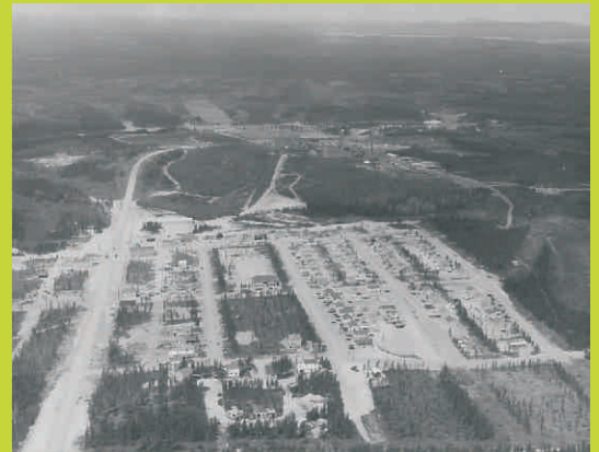
Vue aérienne de la Ville de Chapais en juin 1956. En arrière plan, la mine Springer, dont le chevalement a été incendié en octobre de la même année. Fonds SHRC
