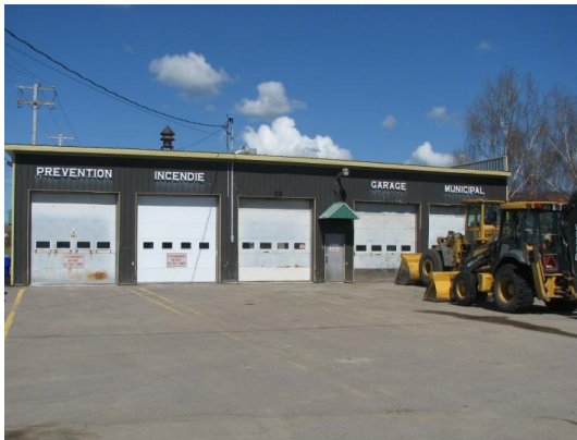
Garage et caserne de pompiers actuels. (4 760 pi 2 )
