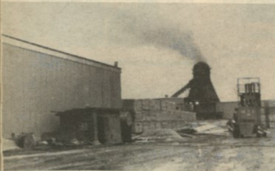
Une vue extérieure de l'usine, on peut voir des empilades de bois au sortir du séchoir.
