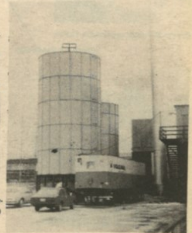
Voici les installations thermiques qui devraient entrer en service en mars prochain chez Barrette-Chapais.
